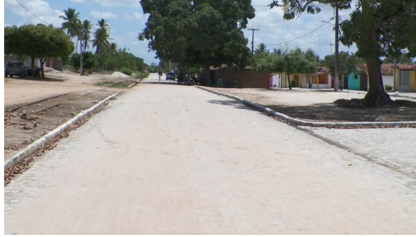
Pavimentação programada e projetada para o Bairro Lagoa de Pedras.
