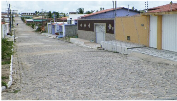
Conclusão das etapas programadas para a recuperação da pavimentação na operação tapa buraco no Bairro da Lapa.
