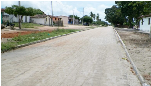
Conclusão da pavimentação do Bairro Lagoa de Pedras.
