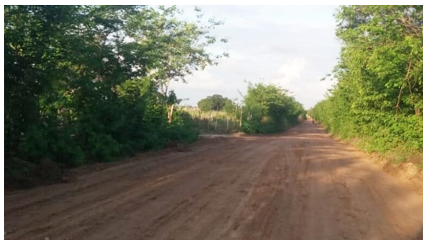
Serviços de terraplanagem nas estradas do Bairro Lagoa de Pedras, zona rural do município. Melhor acessibilidade oferecendo condições de tráfego para todos os tipos de veículos, dos mais simples até os automotores e carroçáveis.
