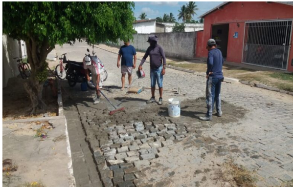
Continuidade da operação tapa buraco no Bairro da Lapa na Rua São Francisco.
